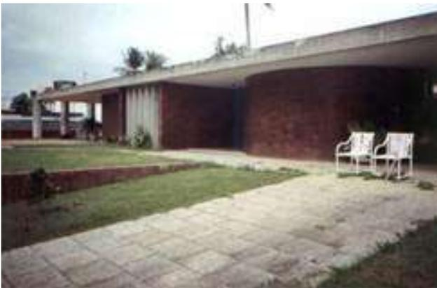
Figura 11- Presença de brises em concreto armado e fachada em tijolo aparente. Residência Otacílio Campos, Acácio Gil Borsoi, 1966.
