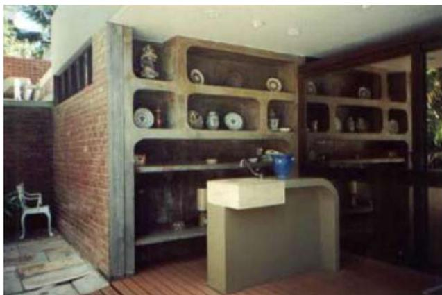
Figura 05 - Estante e balcão: ambos utilizando concreto aparente. Residência Antônio de Pádua, Acácio Gil Borsoi, 1966.
