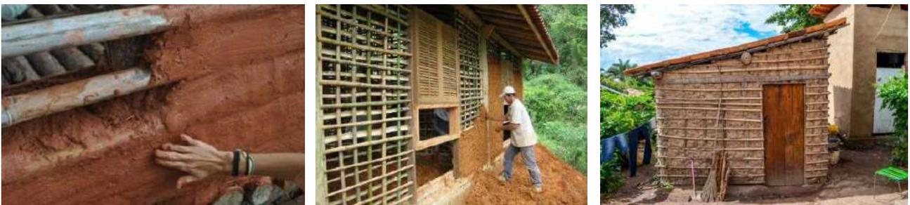
Figura 03 - Casa de taipa: barreamento (foto: Margem Arquitetura); Figura 04 - Construção de taipa de mão (foto: Vai com Tudo); Figura 05- Casa de Taipa de Mão.
